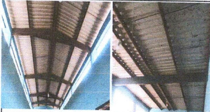
Foto1: Sustitucion de techo del establecimiento y mantenimiento de la estructura de soporte de metal.
