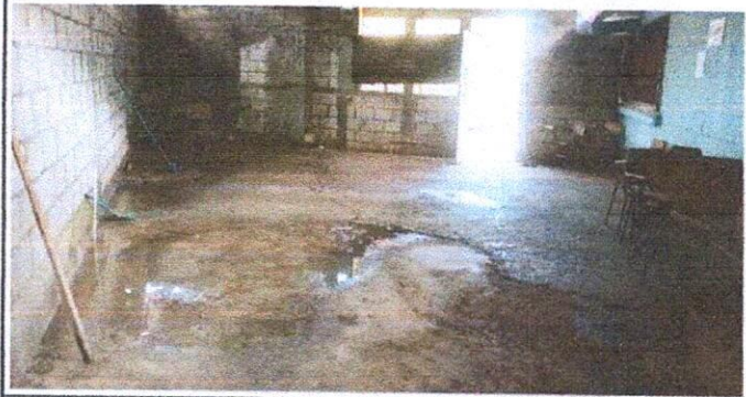
Foto 2: Sustitucion de piso de concreto a piso ceramico
