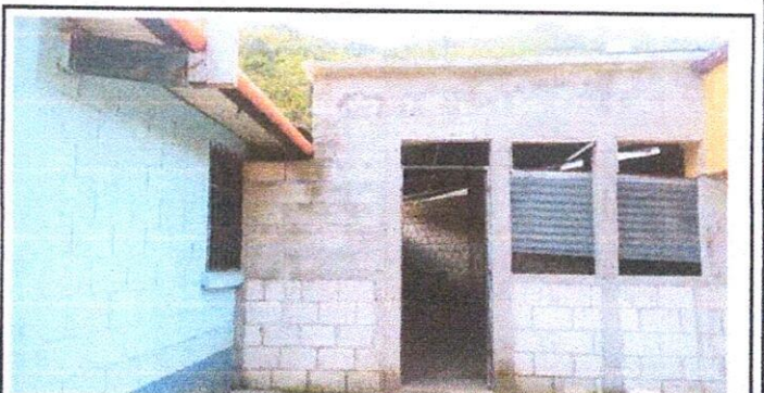
foto: 6 Colocacion de puertas y ventanas de la cocina.
