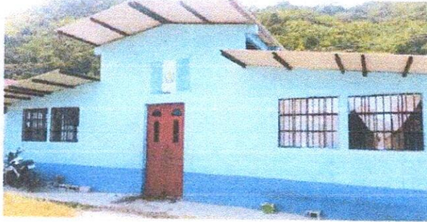
Foto1: Sustitucion de 4 balcones de la parte de enfrente del establecimiento.
