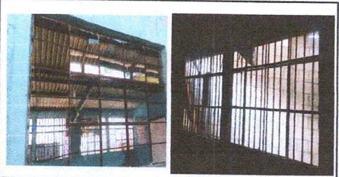
Foto 5: Sustitucion de ventanas de estructura de metal con vidrio de 5mm de 2.00 mts x 1.10 mts
