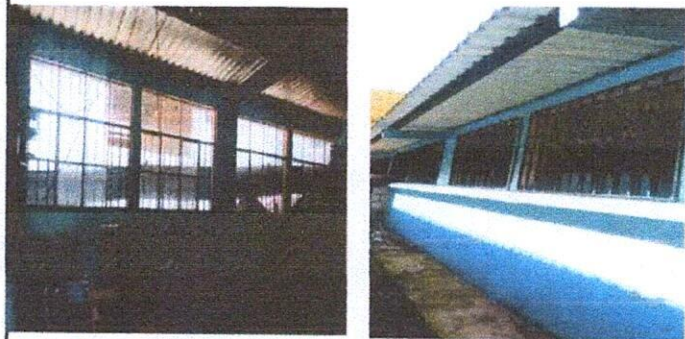
Foto 4: Mantenimiento de balcones
